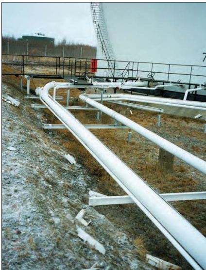
Shell, öljyputkiston saneeraus, Oulu
