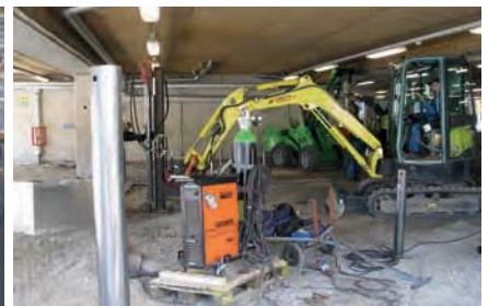
ORT- ruuvipaalu ilman pintakäsittelyä. Putki \varnothing 114,3 \times 6,3 mm, laippa \varnothing 250 mm. Parkkihallin lattian saneeraus. Suunnittelukuorma 140 kN, BDA-mitattu kuorma 187 kN, paalupituus 16 m.
