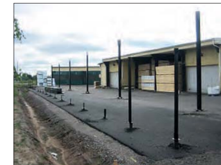
Perustukset asfaltin läpi
