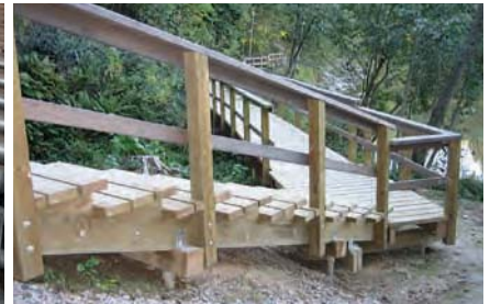
ORT-ruuviperustus kuumasinkitty. Putki \varnothing 60,3 \times 2,9 mm, laippa \varnothing 150 mm
